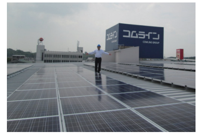
本社ビルの屋上も 太陽光発電の場として活用
